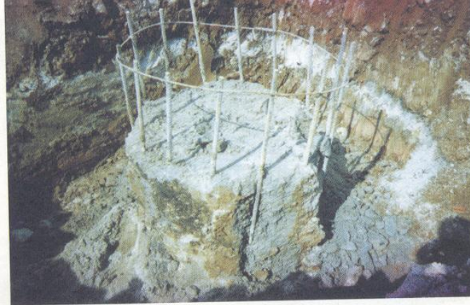
Figura 5.1.2.1.- Estaca Hélice com argamassa de baixa resistência nos seus 2,20 m de extensão a partir do topo
