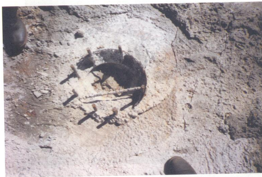
Figura 5.1.2.1.- Estaca Hélice com argamassa de baixa resistência nos seus 2,20 m de extensão a partir do topo
